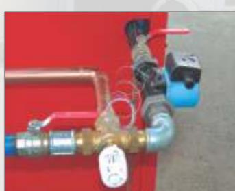
Kotovi snage 40 i 60kW mogu da se isporuče u kompletu sa hidrauličnom skretnicom i trokrakim mešnim ventilom sa termoglavom 50/70°C (zaštita kotla od kondenzacije). Postolje kotla je pod vodom i povezano je sa telom kotla za pornom armaturom R1/2" i cevovodom Ø18mm. Za pouzdan rad mora se obezbediti dovoljna cirkulacija vode kroz kotao i postolje.
