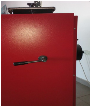
Sl.7. Položaj ručice klapne kotla samo pri potpaljivanju kotla
